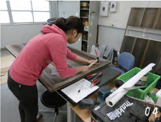
04 雨戸の釘を打ちなおす
