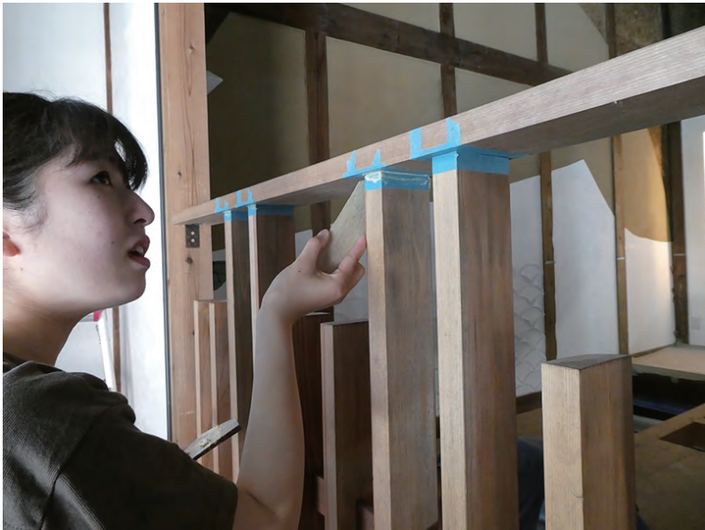
手すり子と笠木の隙間を補修
