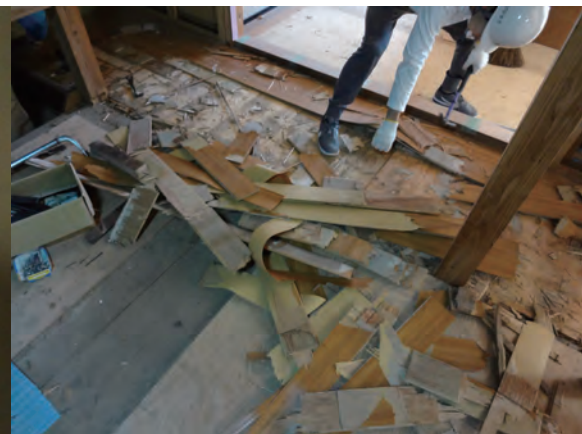
2階中廊下床の解体
