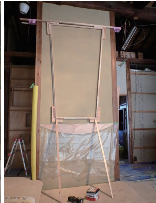
帆の部分の型枠を作成
