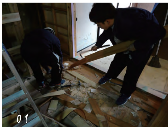
2階廊下の床材を解体
