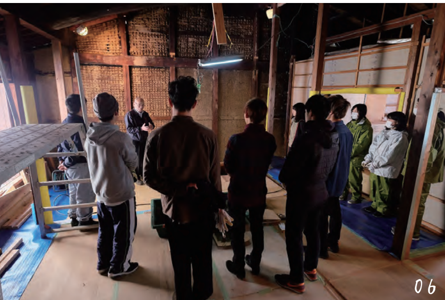
06 中村技建工業の会長による土壁塗り指導
