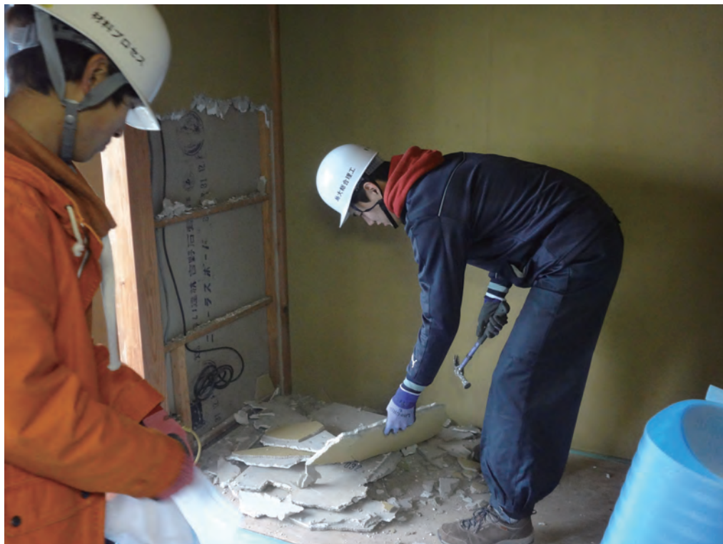
2階床の間壁の解体
