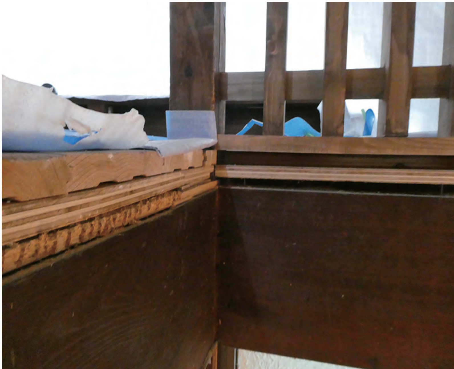
吹き抜けにしたことで、床板が露出している
