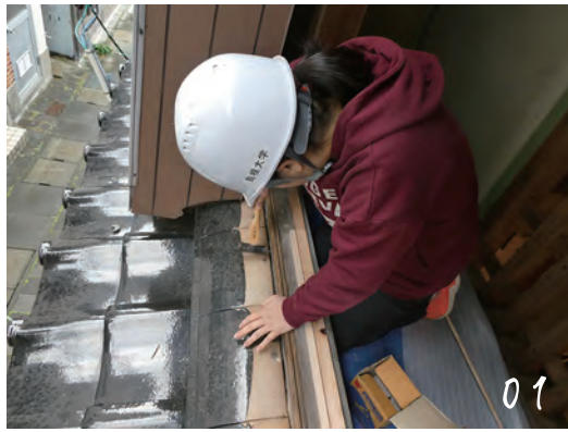
01 雨戸の敷居の補修
