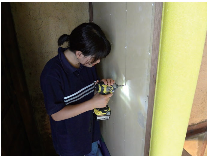
石膏ボードをビスにより固定
