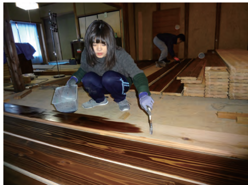
杉板フローリングに柿渋を塗る
