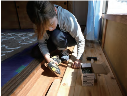
フローリングの固定
