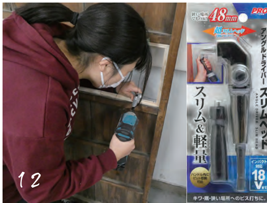
木枠の固定にはアングルドライバーを使用した
