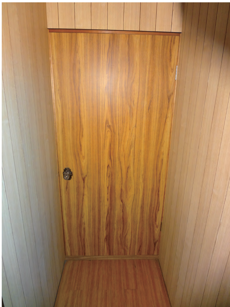
改修前の中廊下の扉
