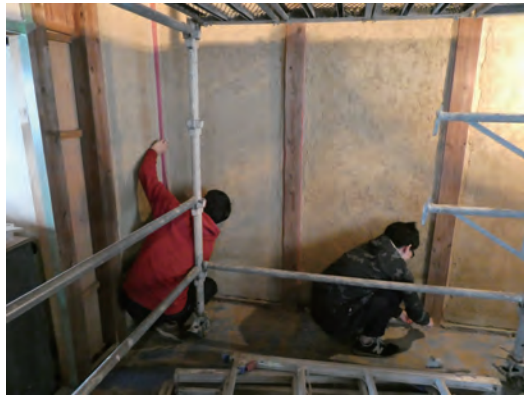
マスキングテープを柱に貼る
