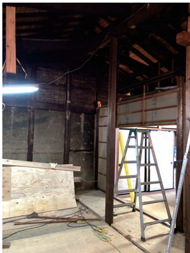
不安定な柱と梁を取り除いた
