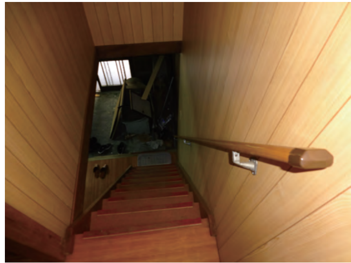
改修前の階段
