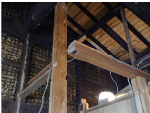
解体したことで見えてきた柱と梁
