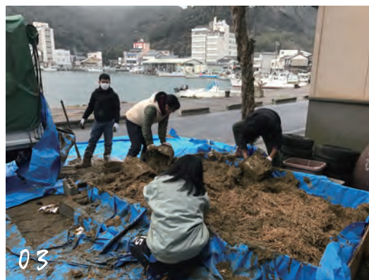
03 土と藁を混ぜている
