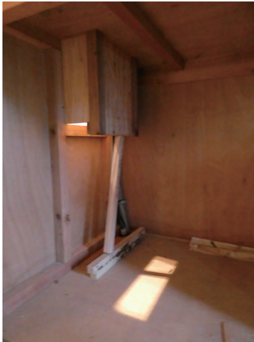
ニッチの裏側（押し入れ）
