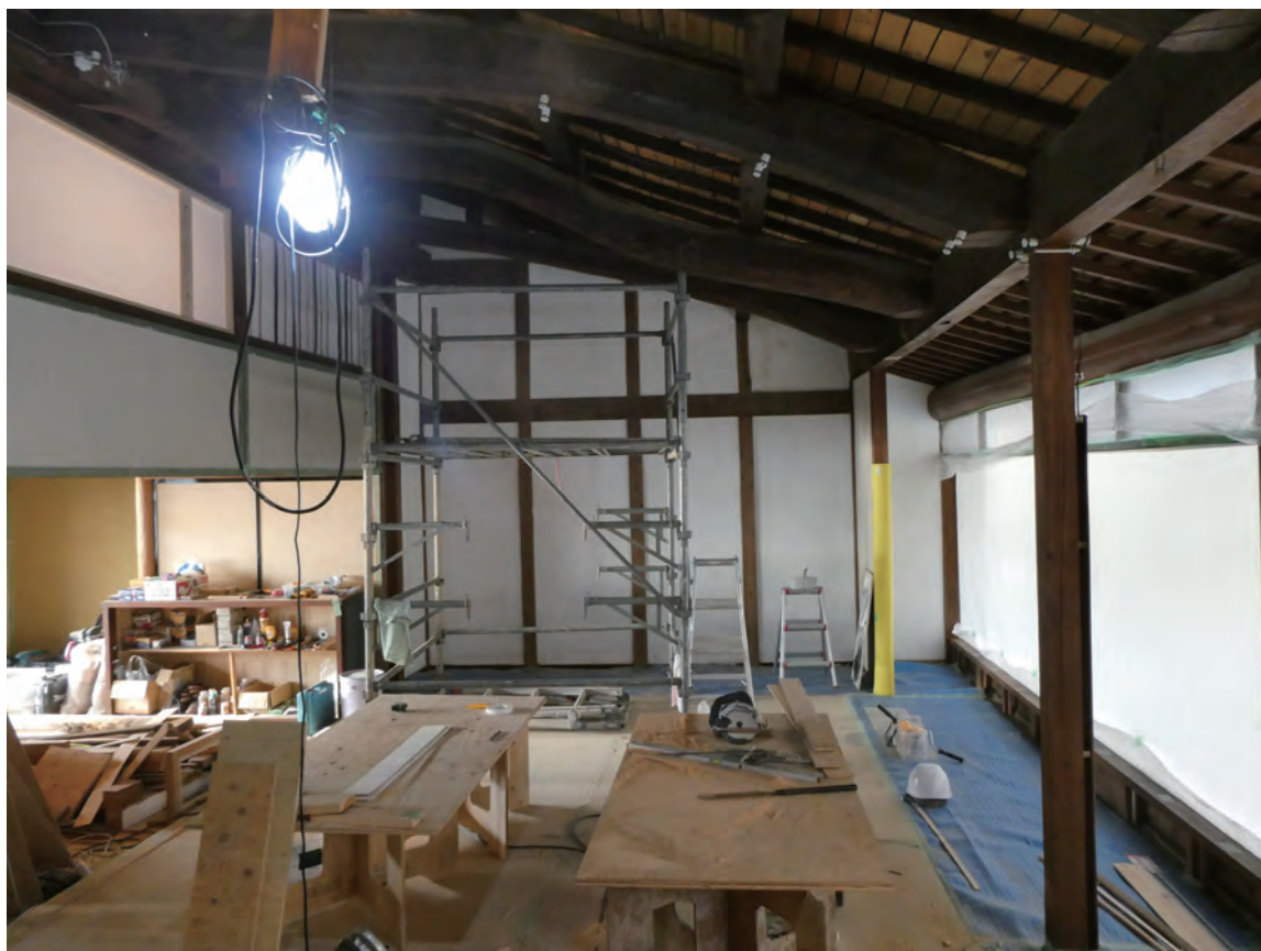
漆喰下地塗り
