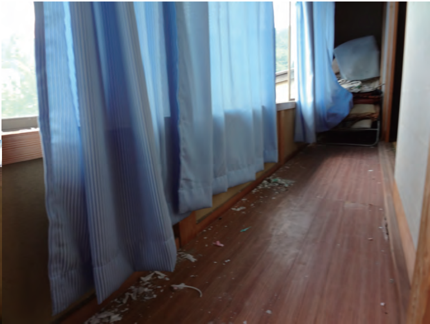
改修前の縁側廊下
