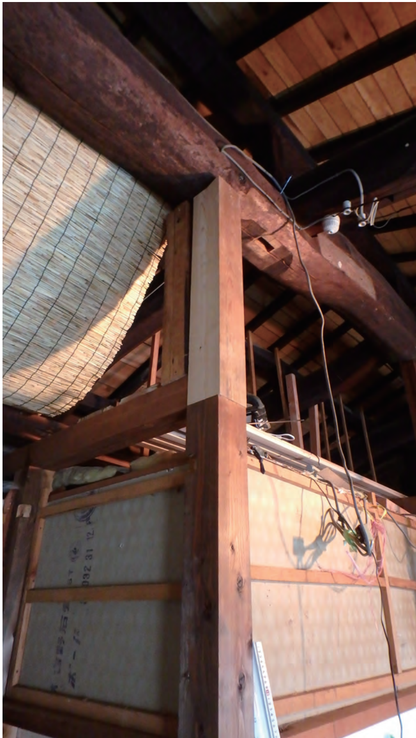
柱の補強・新設
