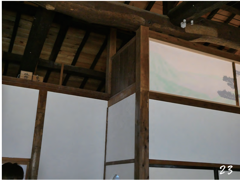
23 投影の点検口
