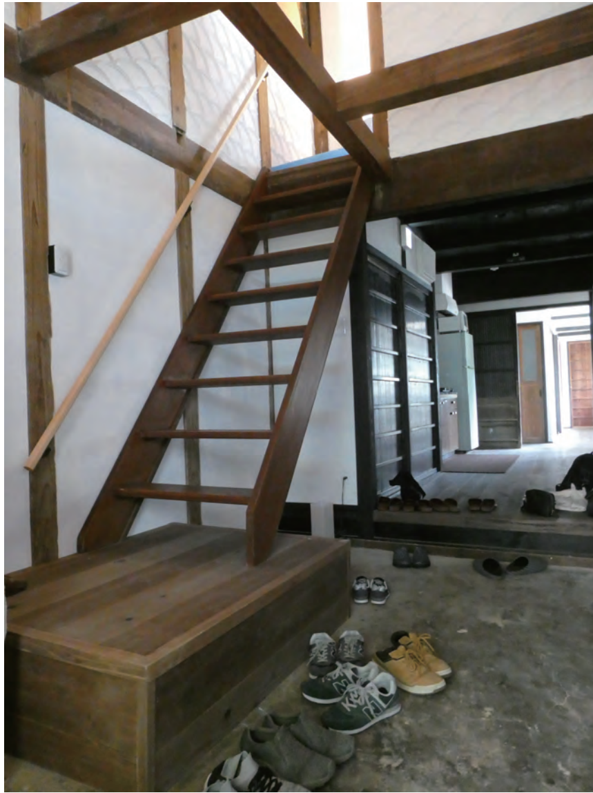
改修後の階段と手すり
