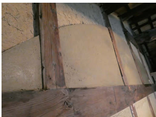
型枠を外した状態
