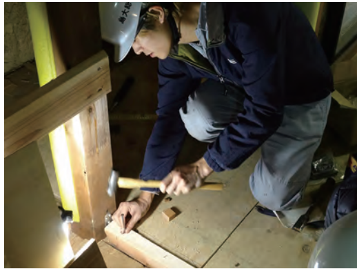
耐力壁の受け材を釘で固定
