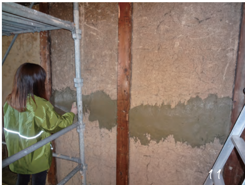
貫の部分に藁で補強する（貫伏せ）
