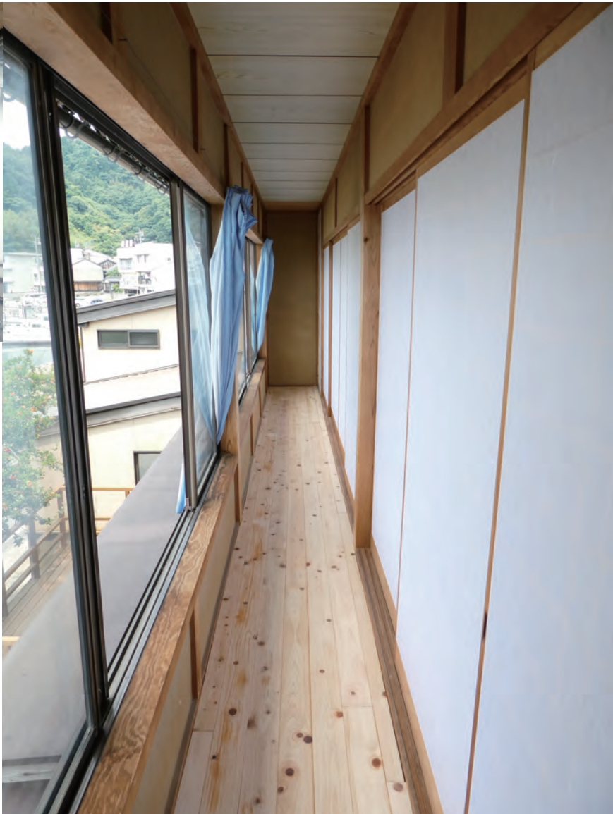
完成した縁側廊下
