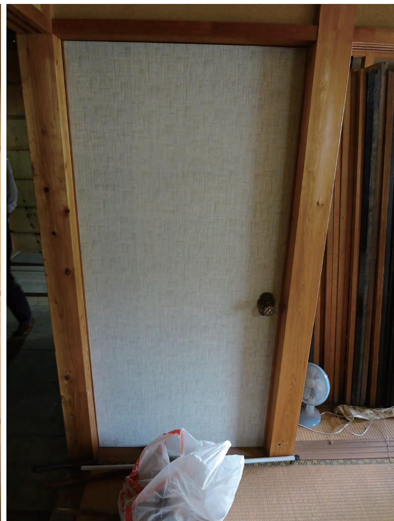
8帖和室から見た扉（改修前）
