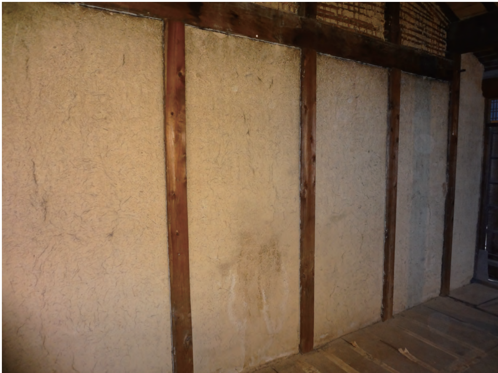
2階北側の既存の土壁
