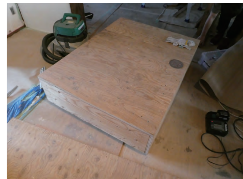
階段 1 段目の土台
