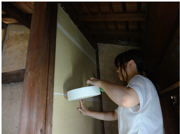
石膏ボードの境目をテープにより埋める
