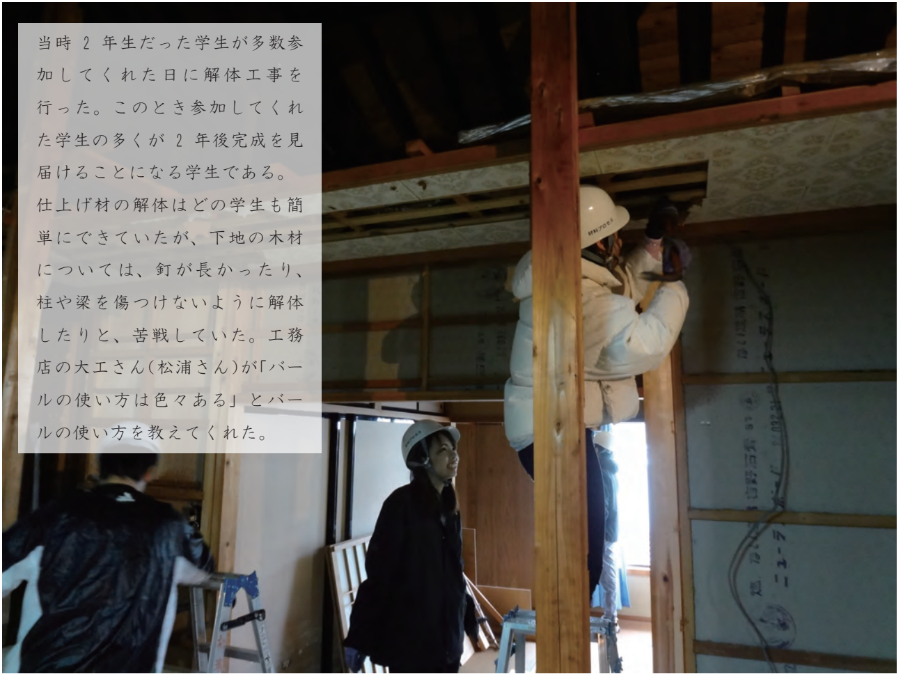
2階廊下天井の解体
