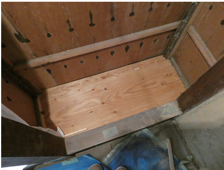
戸袋の底板の補修
