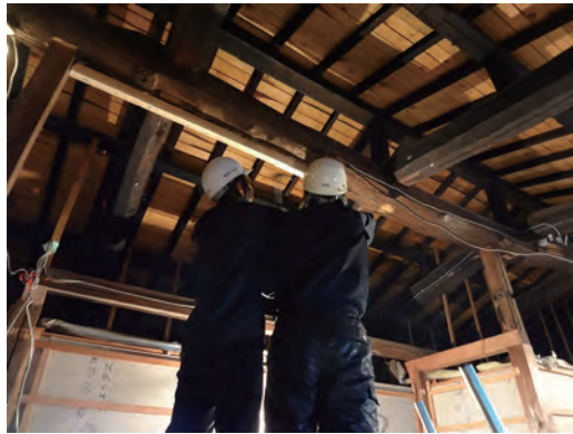
耐力壁の上側にも受け材を固定
