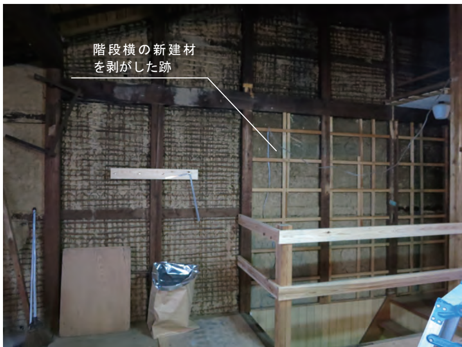
2階南側の既存の土壁
