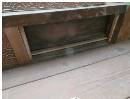
受け材の作成・固定
