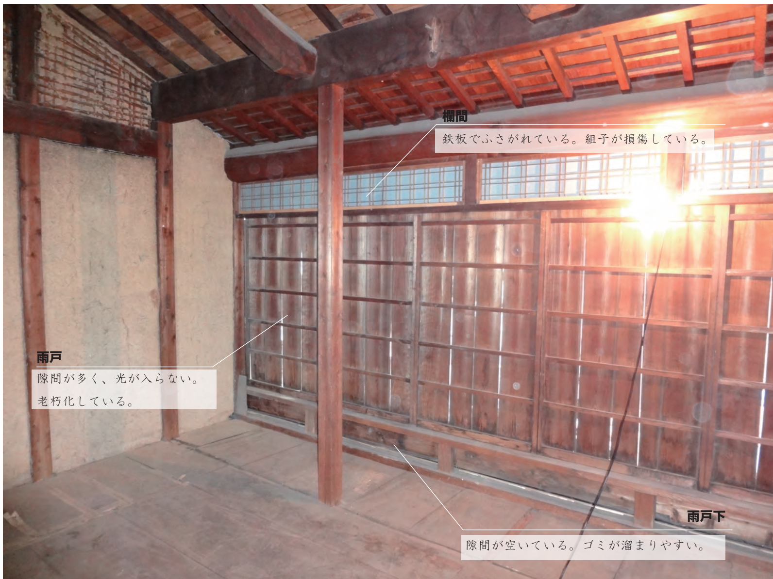
2階大広間の建具（改修前）
