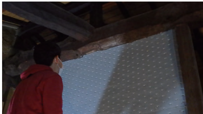
梁の形に合わせてラスボードを整形
