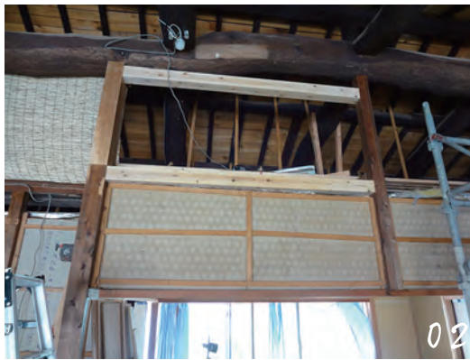
02 障子を設置するための鴨居・敷居の作成
