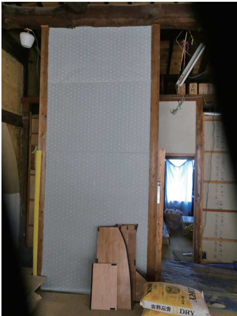
ラスボードの施工
