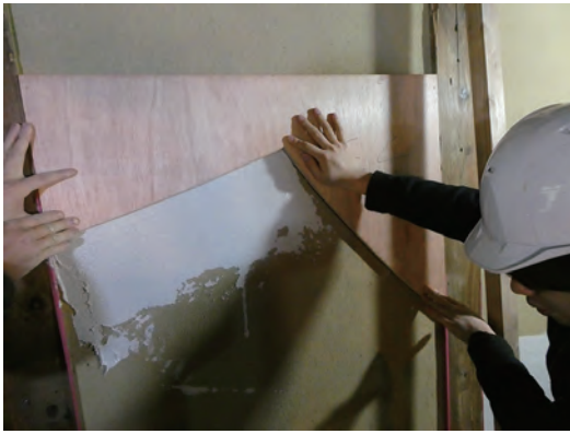
大山の型枠に合わせて漆喰ベースを塗る
