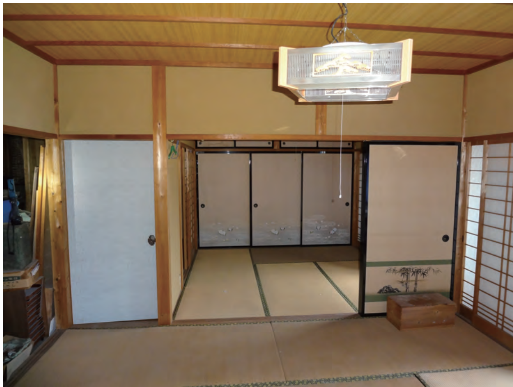
4.5 帖和室（改修前）
