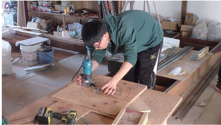
青海波の型枠作り（試作）
