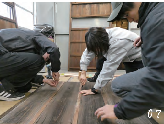
07 雨戸に目板を固定
