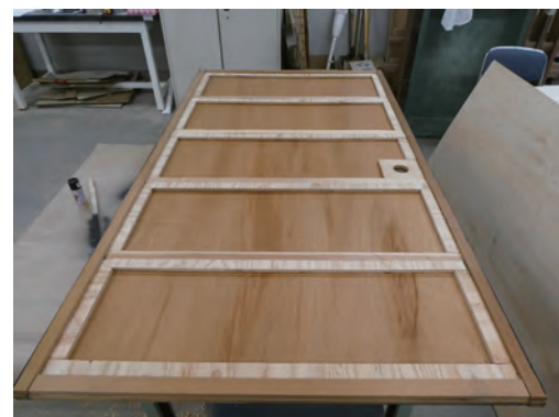
襖の骨部分を補強して受け材を入れる
