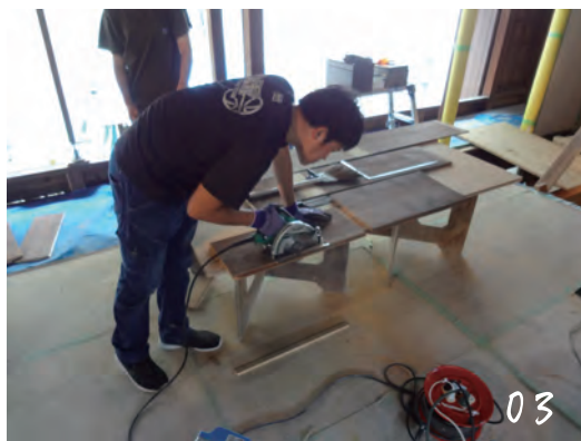
吹き抜け部分の床材を再利用
