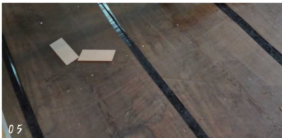
既存の床板の隙間を黒テープで塞ぐ
