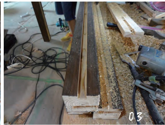
03 障子の枠を設置するためのレール
