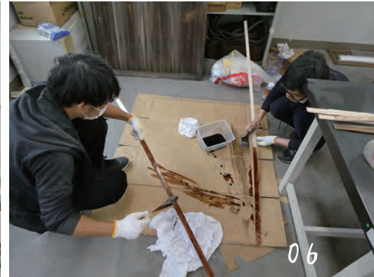
06 雨戸の隙間を補修する目板の作成
