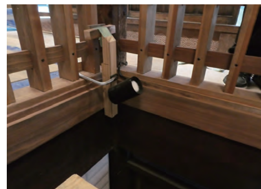
照明の位置の検討と幕板の固定
