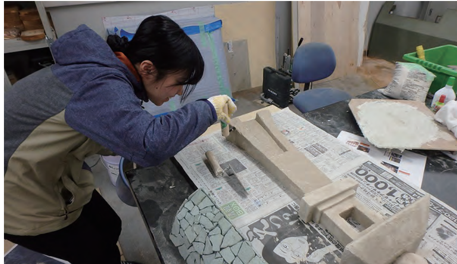
下地材のスーパーカーボンプラスターを塗る
