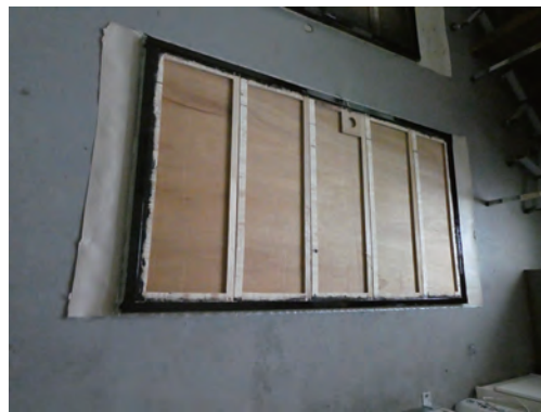
枠を黒色の塗料で塗っていく
