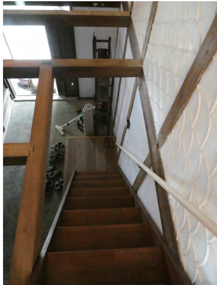
改修後の階段と手すり
