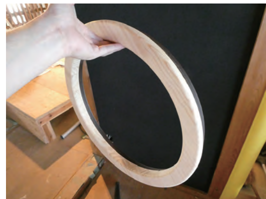
明り取り窓の枠の作成
