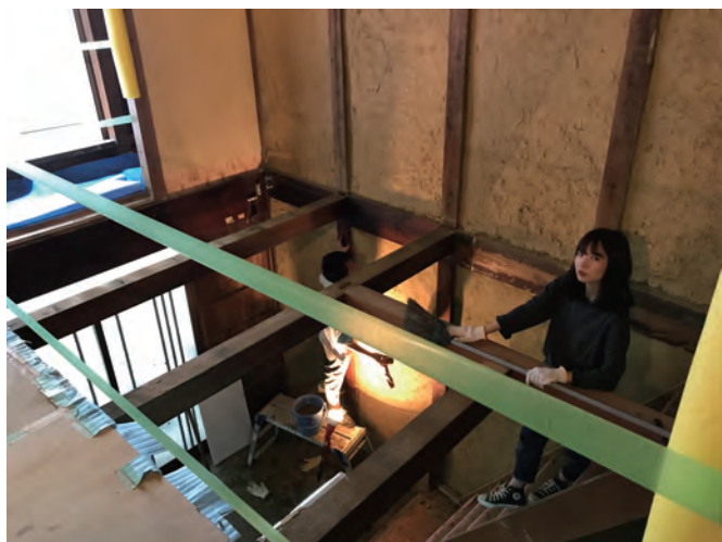
床板を撤去し吹き抜けとした
