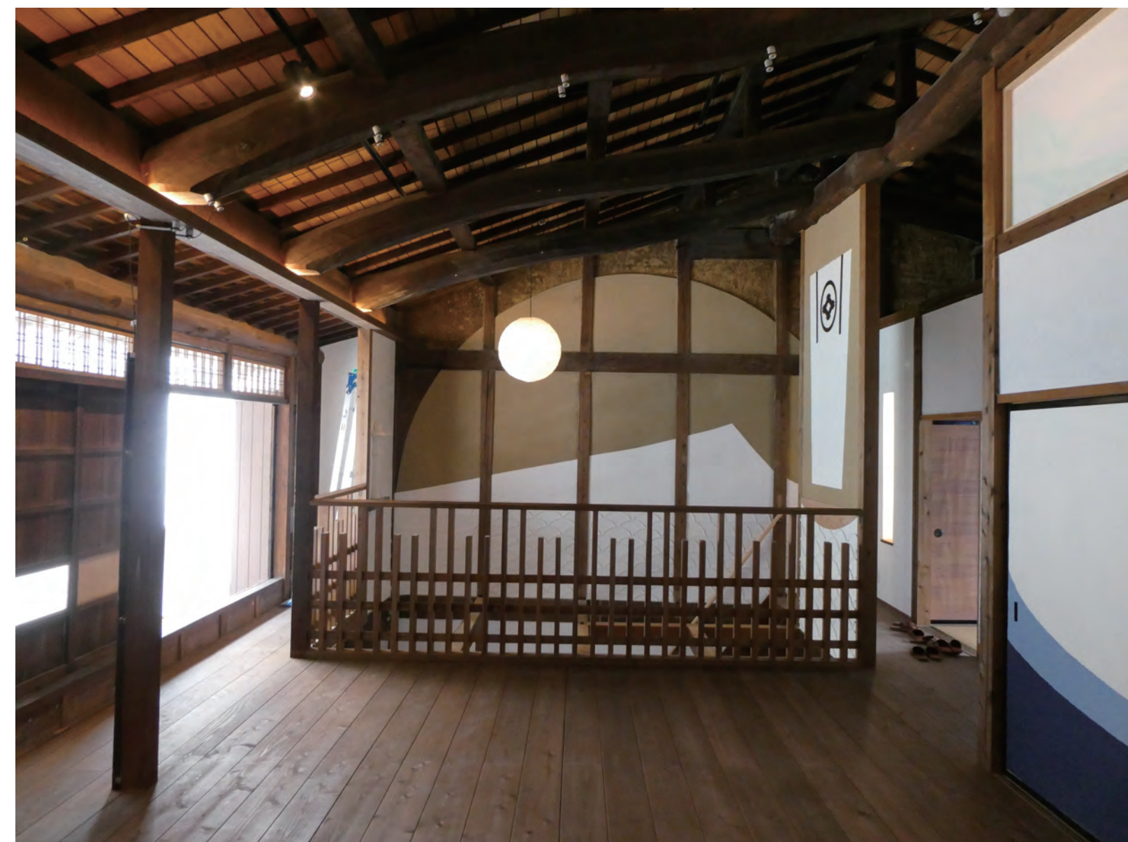
完成した手すり
