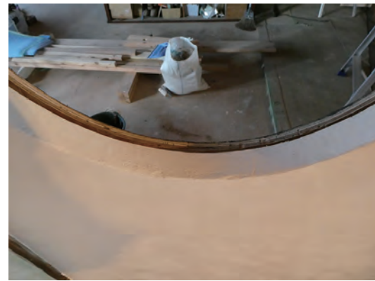
明り取り窓の漆喰
