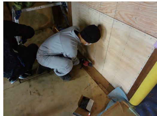
12mmの構造用合板1級をビスにより固定
