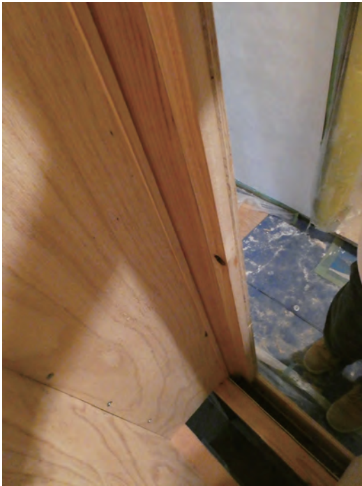
ニッチの内部
