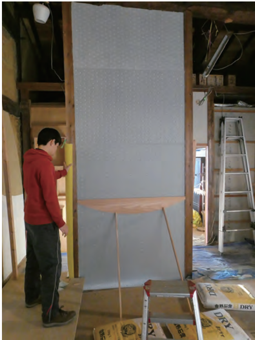
固定した下地の上に船型の木材を貼りつける 中塗り
