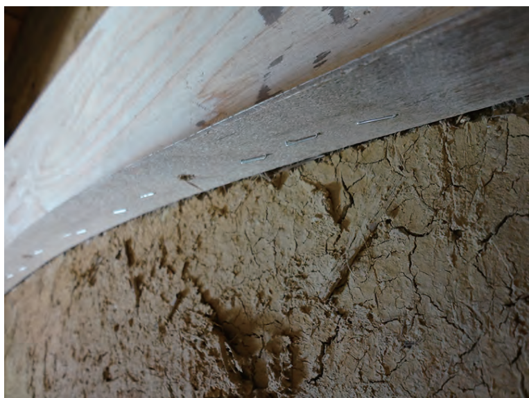
大山の型枠を設置する
