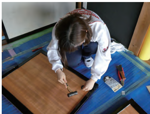
襖の引手を設置
