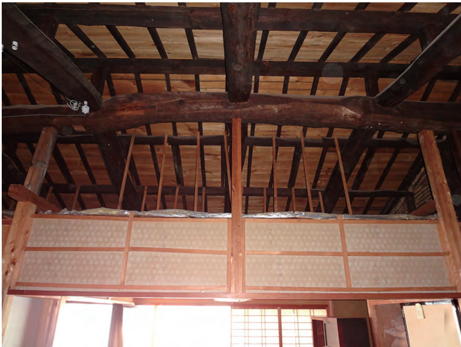
改修前の天井裏
